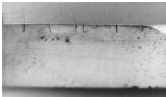
Рис. 4.15. Срез трубы, поврежденной в результате тепловой усталости
