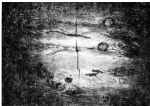
Рис. 4.36. Усталостная трещина в стыковом сварном соединении, расположенная поперек шва
