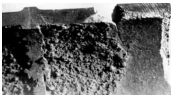
Рис. 4.54. Поражение металла трубы межкристаллитной коррозией
