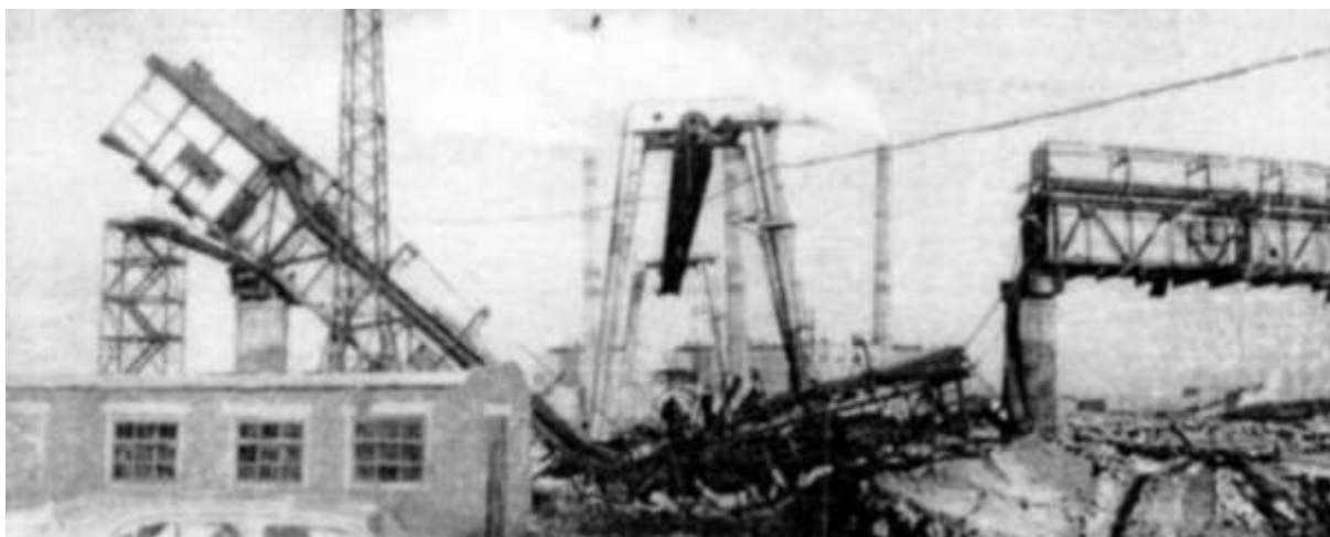
Рис. 4.86. Общий вид разрушения
