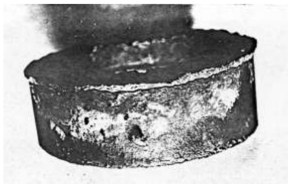
Рис. 6.26. Эксплуатационное повреждение паропровода котла №12 Томь-Усинской ГРЭС
