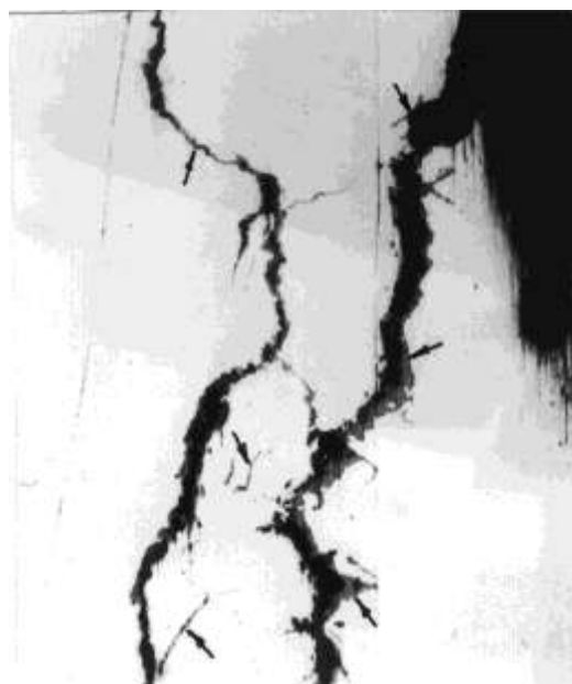
Рис. 4.99. Вторичные трещины от поверхности разрушения
