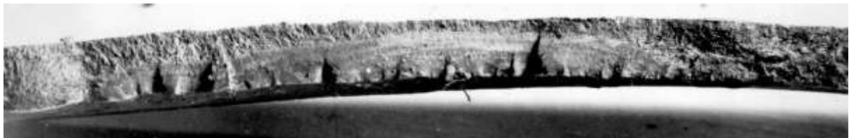
Рис. 4.92. Старая трещина в изломе
